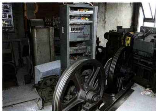
Les vieilles machines sont évacuées du bâtiment avec démolition.
