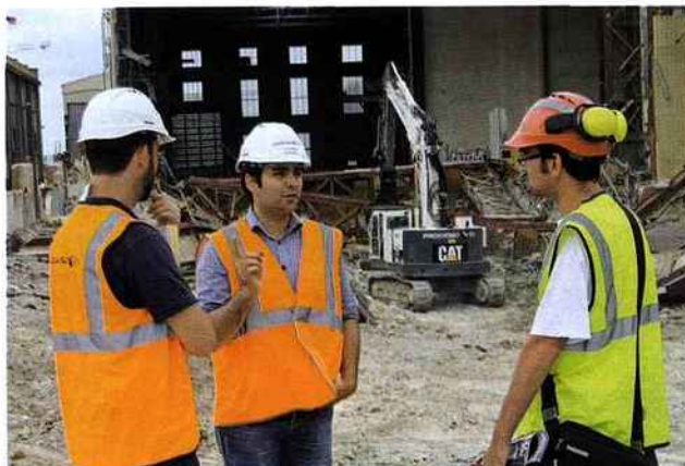
Thomas Martin, au centre, règle des détails avec Alban Perreault (à droite) et Alexandre Cornet, Conducteur de Travaux de la société Occamat.
